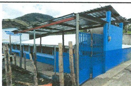
Foto 6: CUBIERTA DE LAMINA ÁREA DE PARVULOS
