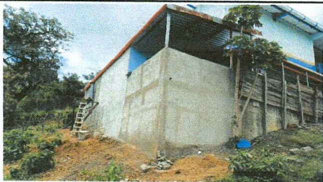
Foto1: MANTENIMIENTO CON REPELLO ÁREA DE COCINA
