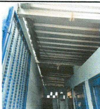
Foto 5: SE AÑADIO CUBIERTA DE LAMINA Y ESTRUCTURA DE TECHO ÁREA DE BAÑO
