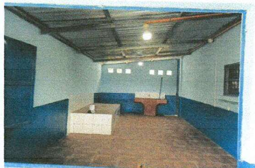
Foto 2: MUROS DE BLOCK CON REPELLO Y PINTURA ÁREA DE COCINA
