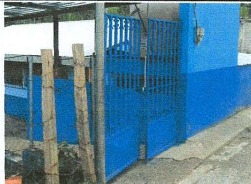
Foto 2: MANTENIMIENTO DE PINTURA ENTRADA PRINCIPAL
