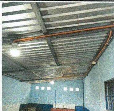
Foto 3: ESTRUCTURA DE TECHO Y CUBIERTA DE LAMINA Y CABLEADO ELECTRICO
